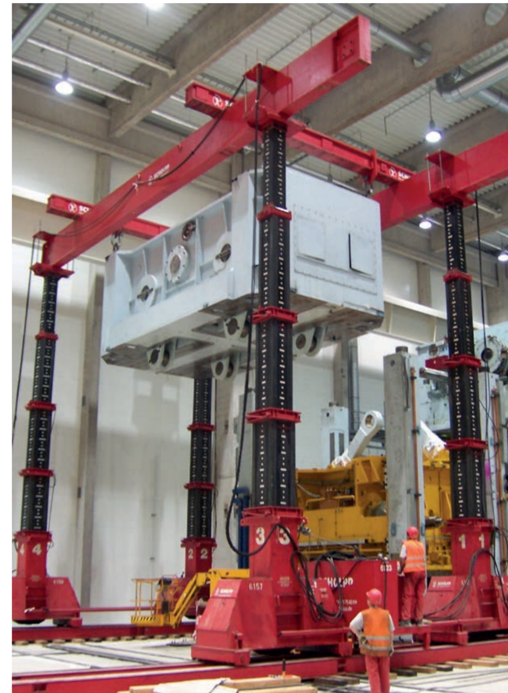
Remontage der Pressen im ungarischen Auslandspresswerk.
