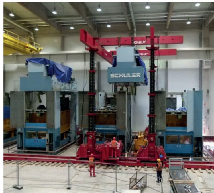
Verladung der Pressenköpfe in das Schiff nach Ungarn. Remontage der Pressen in Ungarn.
