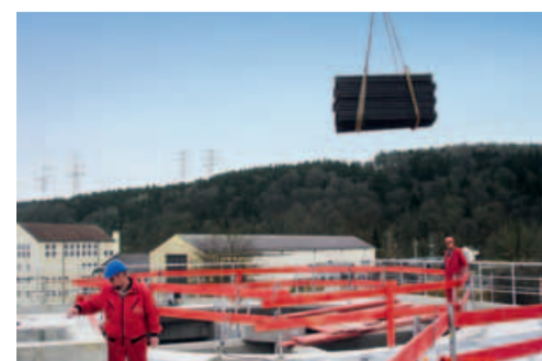
Materialnachschub schwebt über den Luftweg ins Kraftwerksgebäude
