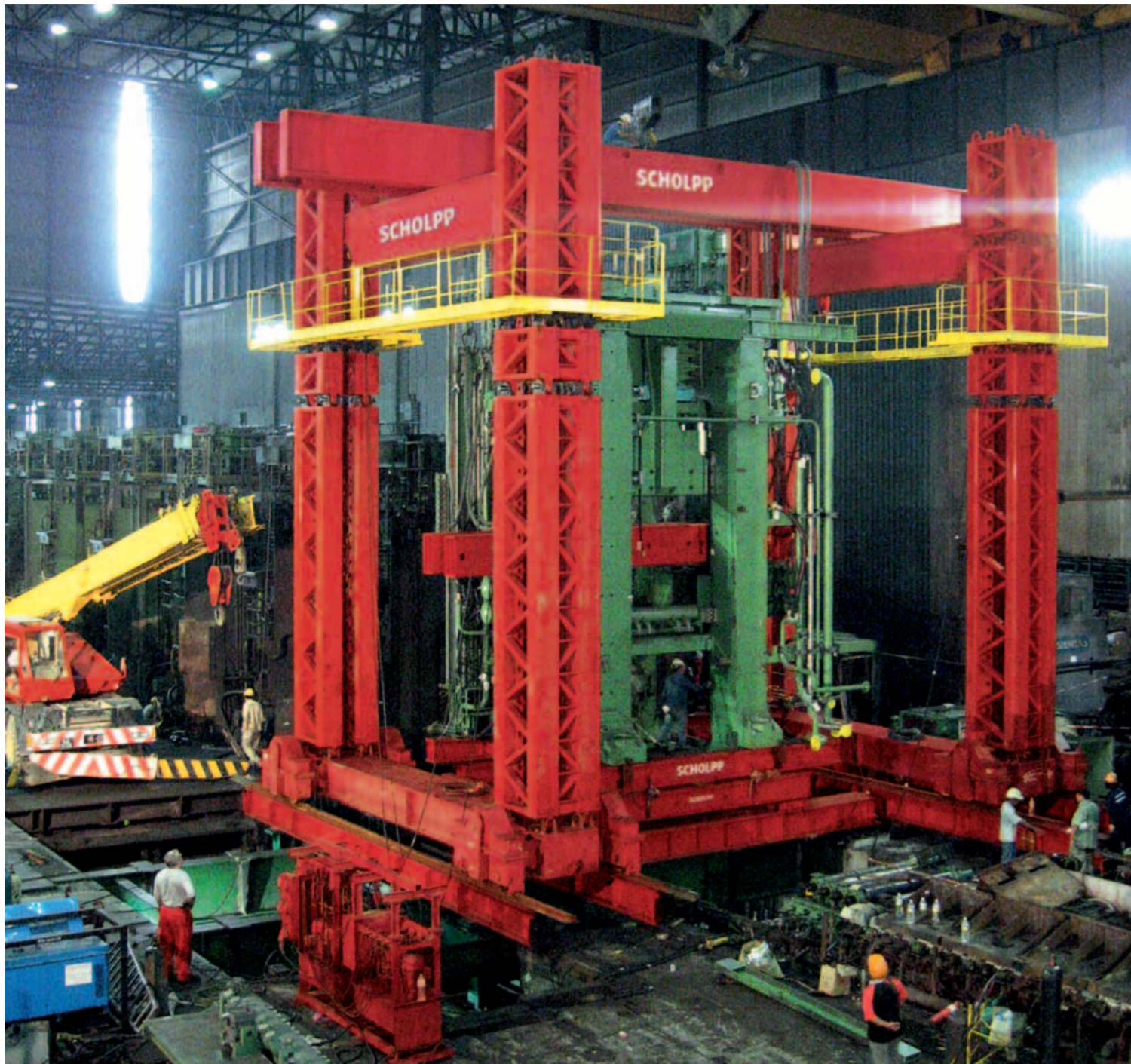
Auf die Minute genau war der Einschub eines Wälzgerüsts in die Wälzlinie bei Megasteel geplant
