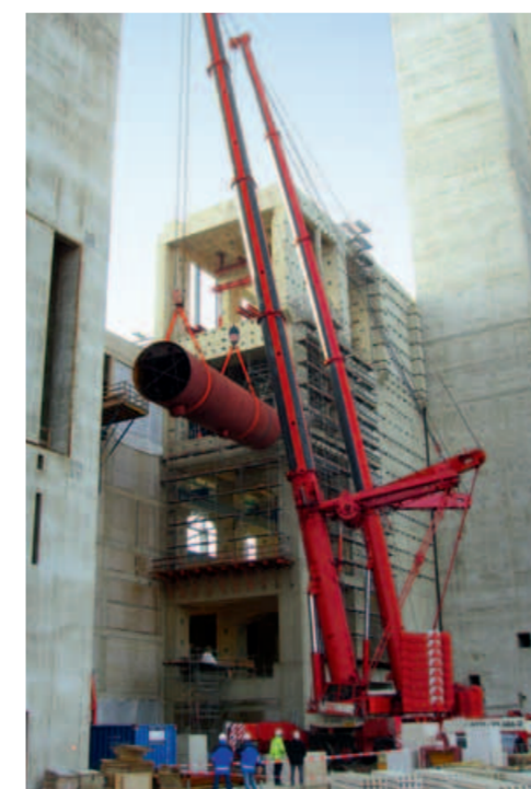
Kraftwerk Neurath: 80 Tonnen in 38 m Höhe
