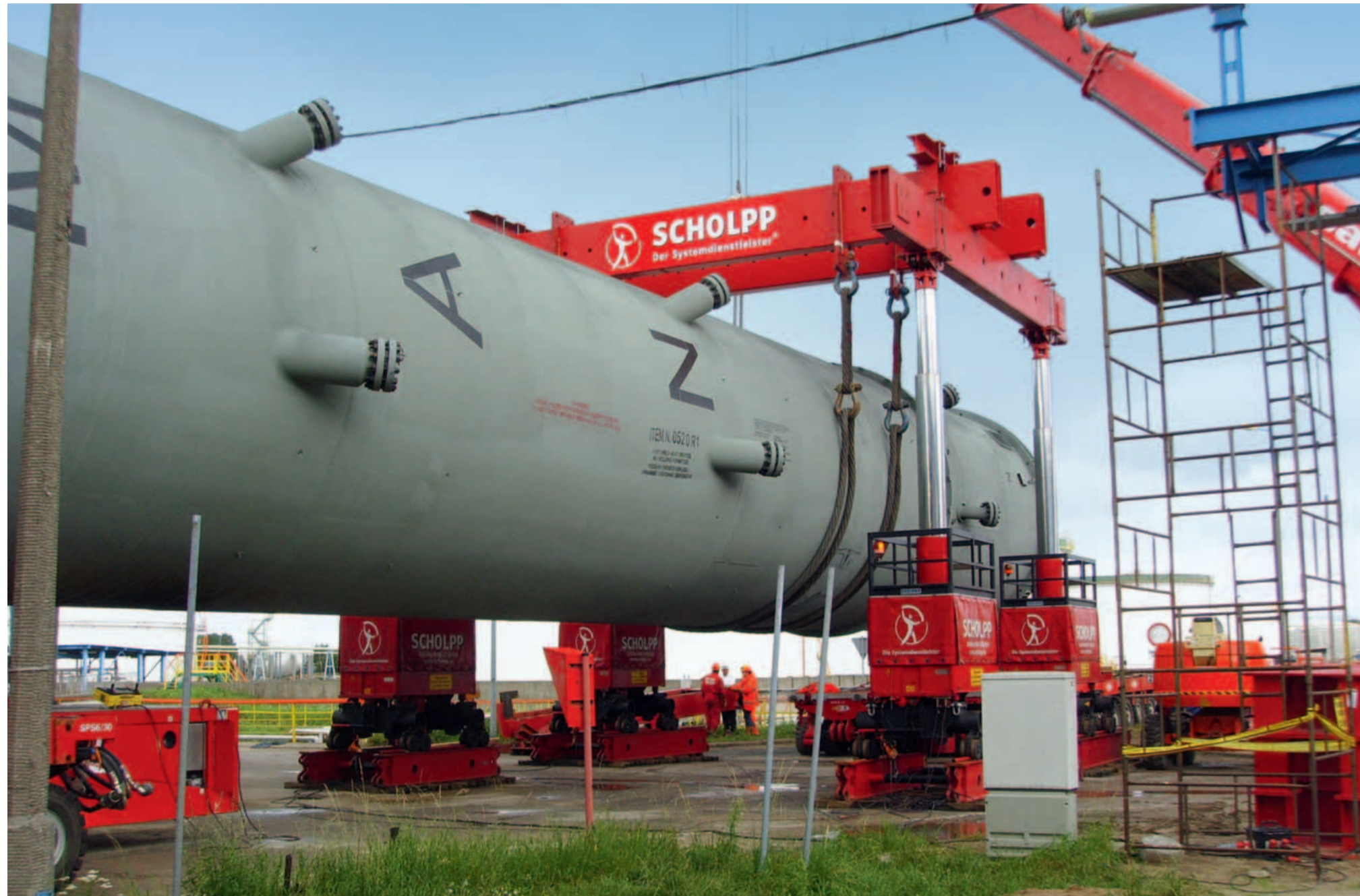
Lotos Raffinerie Gdansk: 700 Tonnen am Haken ...
