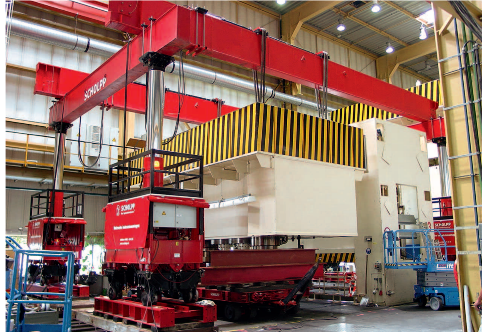
Einsatz des Hubgerüsts S-HG 620 bei der Demontage (unten) und beim Setzen des Kopfstückes
