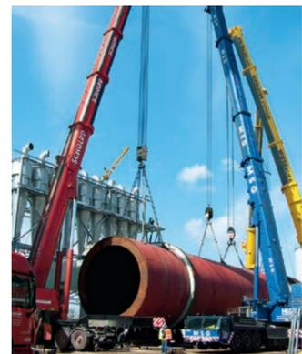
SCHOLPP koordiniert den millimetergenauen Simultanhub von vier Kranen
