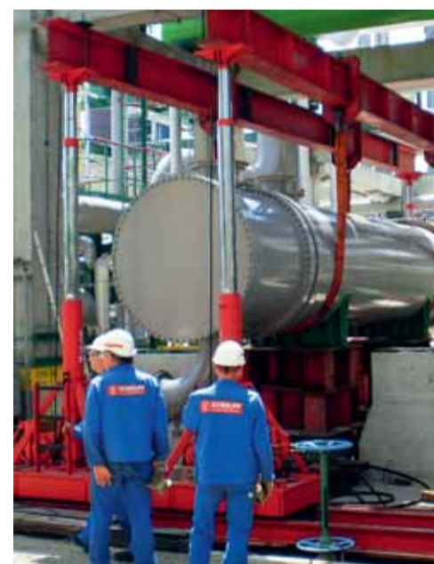
Der Wärmetauscher wird mit dem SCHOLPP-Hubgerüst TG 95 auf sein Fundament gehoben
