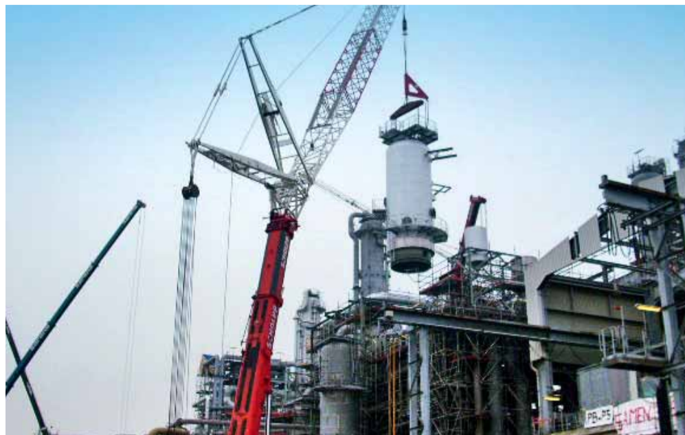
Der SCHOLPP-Kran AC 650 übergibt den Behälter schwebend ...
