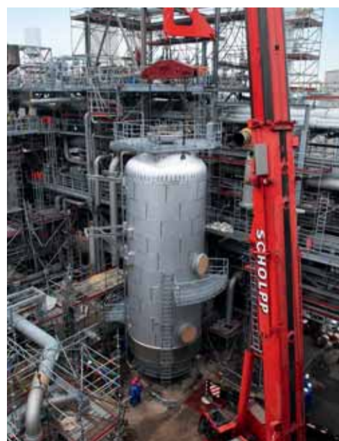
... an den SCHOLPP-Kran AC 300 zum exakten Positionieren
