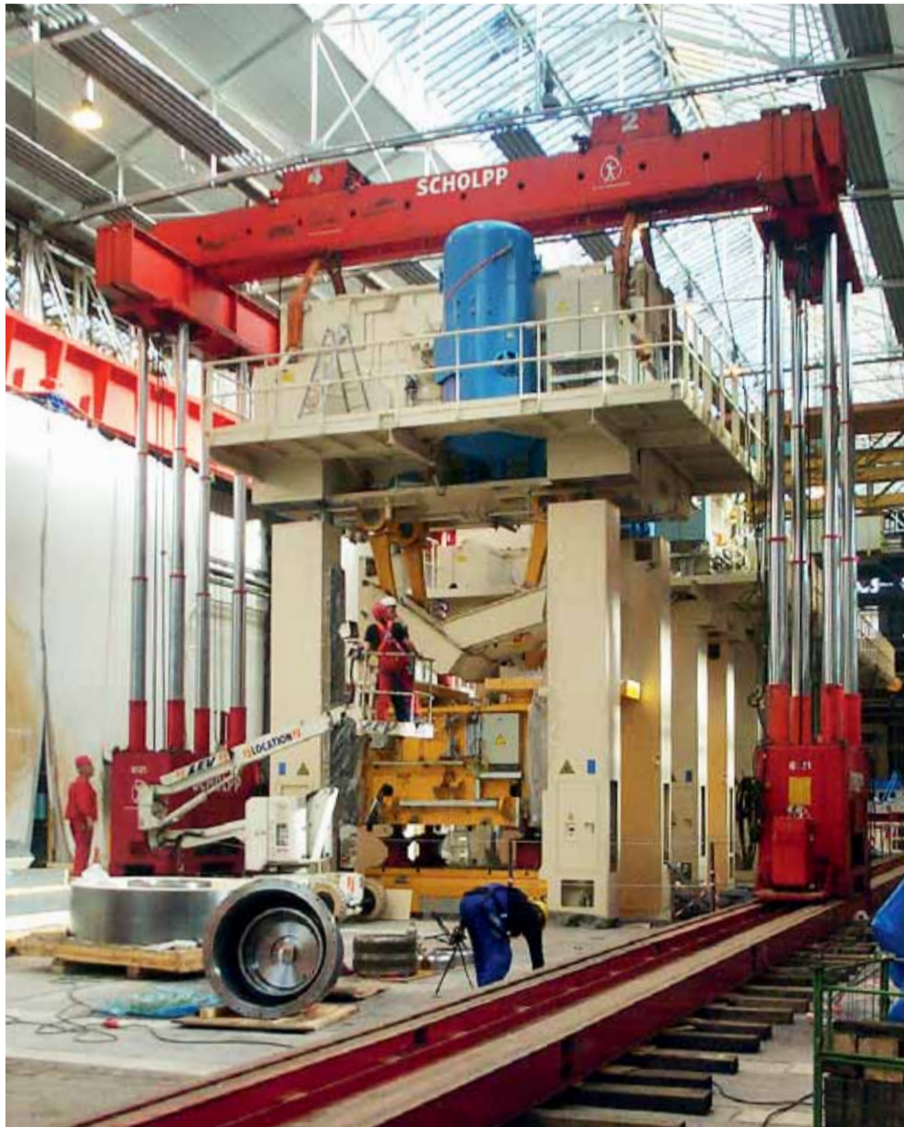
Mit dem Hubgerüst Quadlift wird das 125 Tonnen schwere Kopfstück aufgesetzt
