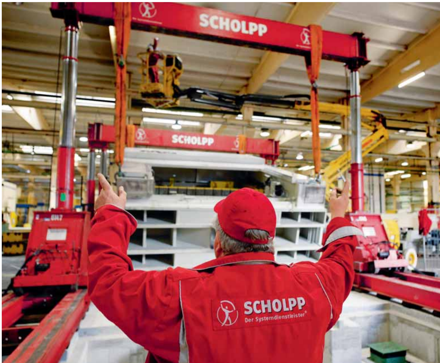
Tandemeinsatz von TG 360 und A 48 beim Heben von 100 Tonnen
