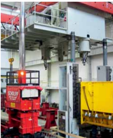
Der Pressenkopf schwebt, noch 30 cm sind zu heben. Unter der Decke wird es eng
