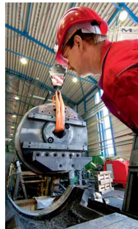
Der Werkzeughalter wird mit Hilfe eines Autokrans vorsichtig aufgesetzt
