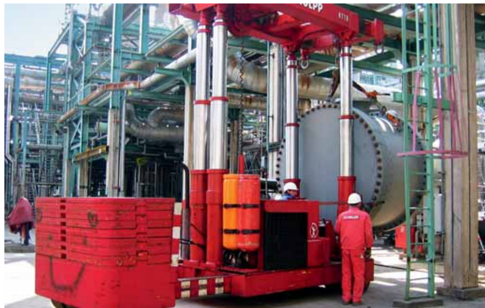
Der SCHOLPP-Boom-Truck verfährt die Vorkammer unter der Rohrbrücke
