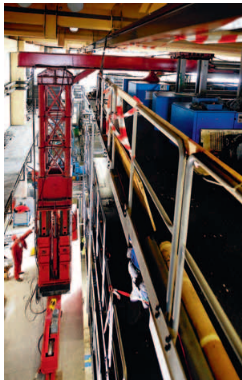
Die Platzverhältnisse bei den Ruhr Nachrichten sind für die Einbringung einer WIFAG Druckmaschine sehr beengt. SCHOLPP positioniert sie bei laufender Produktion zwischen zwei bestehenden Rotationsanlagen.
