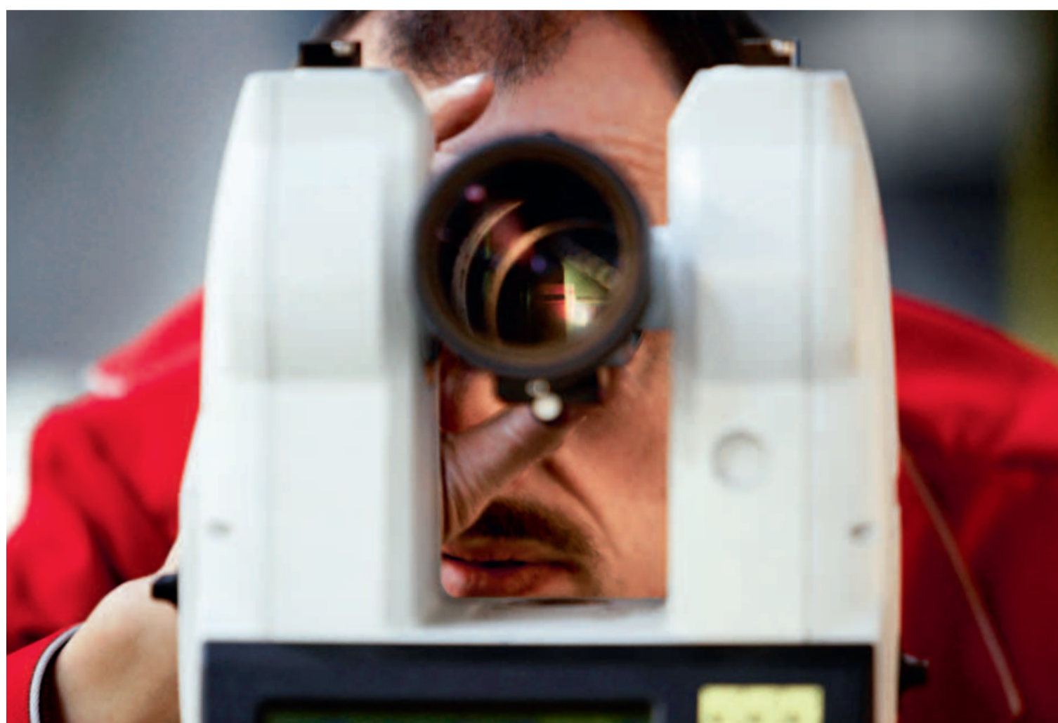
Hightech im Einsatz bei SCHOLPP: Das optische Messgerät „Theodolit“ wird in die Messachse eingerichtet.
