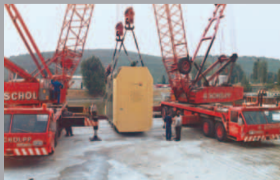
Doppel-Hub: Umschlag eines 100 t schweren Trafos mit zwei Liebherr LG 1130 im Heilbronner Hafen
