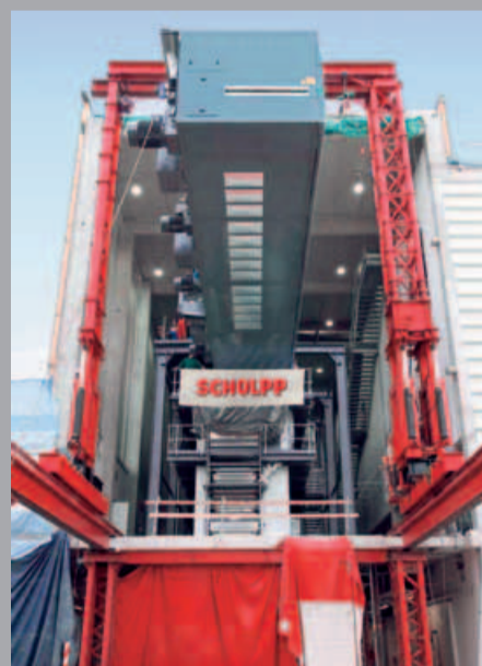
Geschäftsfeld Print&Pack: Montage einer Druckmaschine mit speziell entwickelten Hubgerüsten
