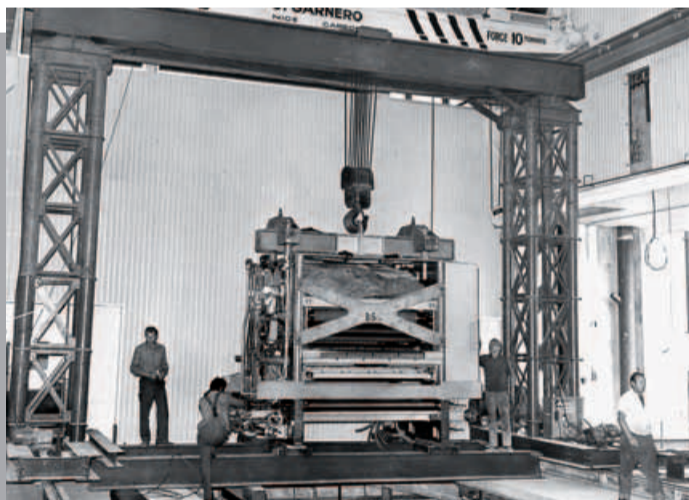
Druck-Werk: Die erste Druckmaschinenmontage läutet 1972 die Ära der SCHOLPP Montage ein
