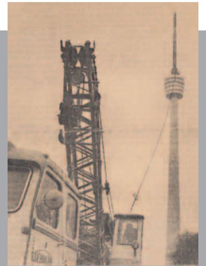
Statik geprüft: Fernsehturm in Schwingung versetzt
