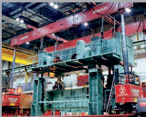
Komplexe Aufgaben: SCHOLPP entwickelt die Systemdienstleistung weiter
