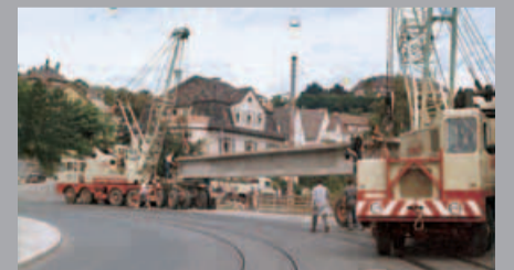
Rasch bauen: Setzen von Betonfertigteilen und Raumzellen
