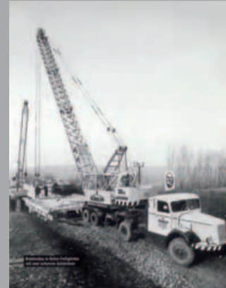
Tandem-Hub: Versetzen einer Brücke
