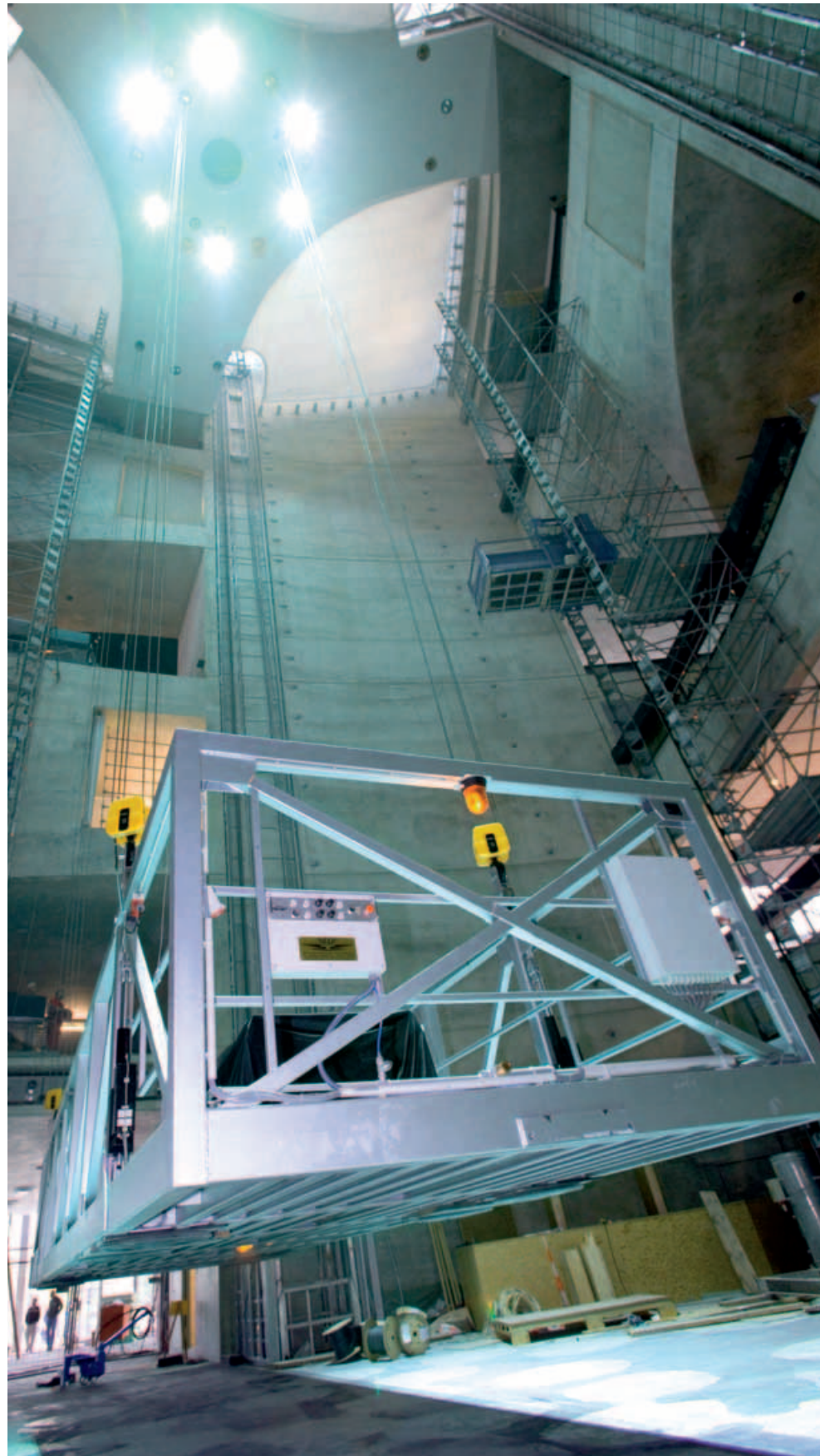
Millimetergenaue Einbringungsarbeiten mit Krankorb, eigens entwickeltem Hubgerüst und „Samthandschuhen“.
