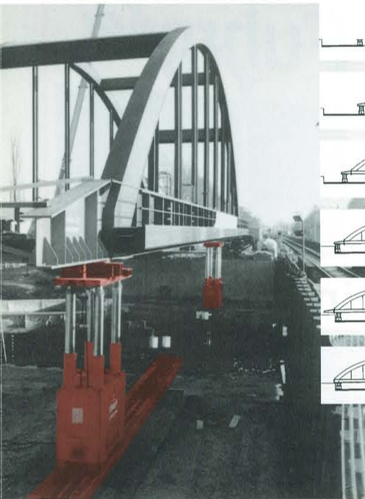
Verschubphasen der 600-t-Brücke in Brieselang
