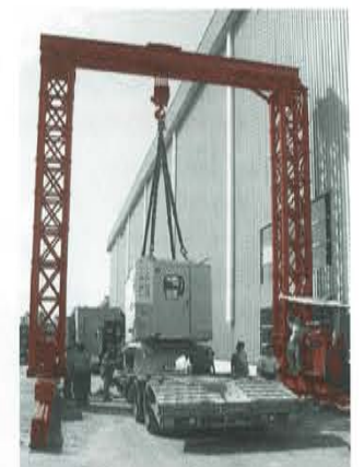
Portal beim Abheben eines Falzes von KBA
