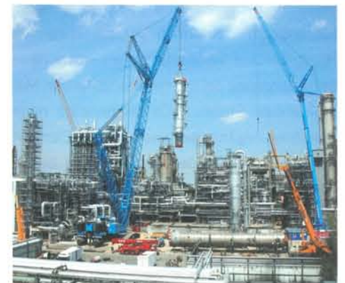
Einheben des neuen Kolonnenunterteiles mit einem 750 Tonnen Raupenkran mit 400 Tonnen Superliftballast. Im Vordergrund die abgelegten alten Kolonnenschüsse sowie das stehend zwischengelagerte neue Kolonnenoberteil.
