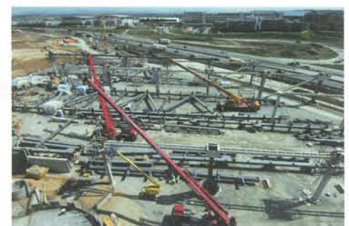
Vormontage der Fachwerke des Parkhauses.
