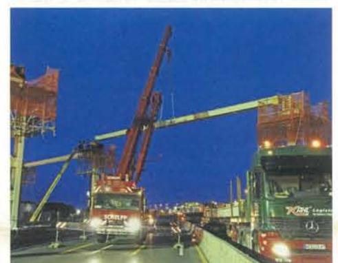
Nachteinsatz auf der A8 – Einbau der Koppel-träger für den Vershub.
