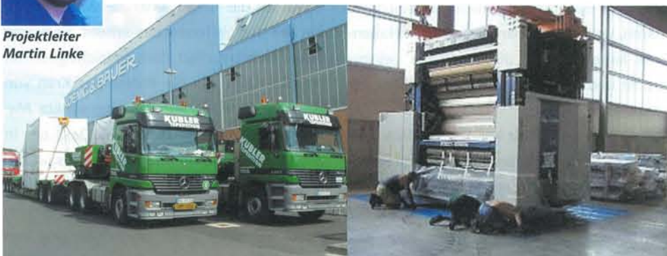
54 mehr als 55 Tonnen schwere Druckeinheiten mussten in einem Wettlauf mit der Zeit über die Alpen in fünf verschiedene Zwischenlager transportiert und fast parallel an sechs Standorten montiert werden.
