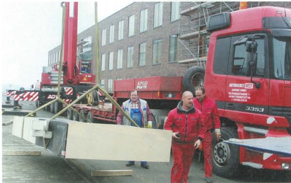
Mit SCHOLPP Autokränen und einem »Fliegenden Teppich« wurden die wissenschaftlichen Anlagen und Gerätschaften sicher verlagert und im neuen Domizil installiert.
