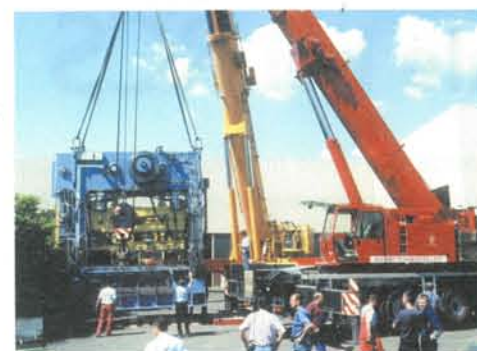
Nach der drei Stunden langen Reise vom Herstellerwerk in Heilbronn zu Layher nach Eibensbach wurde die etwa 120 to schwere Exzenterpresse mit Hilfe von zwei HK 650 und HK 160 Schwerlast-Autokränen von SCHOLPP Kran & Transport bei Scheinwerferlicht entladen.
