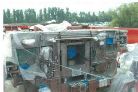
Eine in Brasilien gefertigte Voith-Papiermaschine mit einem Gesamtgewicht von ca. 300 Tonnen musste entladen, transportiert und eingebracht werden.
