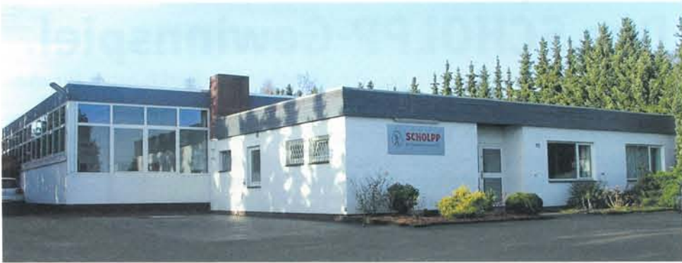
Das neue Domizil der SCHOLPP Niederlassung Hamburg in Stelle.
