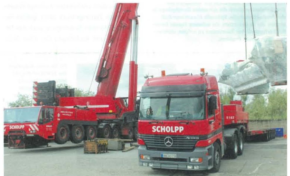
Schwerlast-Tieflader von SCHOLPP und der Projektspeidition Süd, Kübler, übernahmen die Ladung von den beiden Hydraulik-Kränen und beförderten sie über das Stora Enso Betriebsgelände zum Zwischenlagern vor der Produktionshalle.
