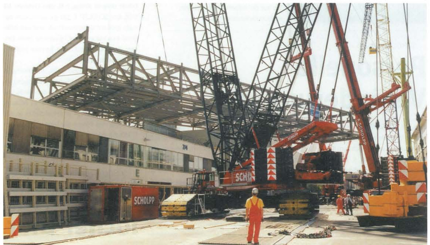
RK 500 im Vordergrund beim Einheben des 190 to wiegenden ersten Teils. HK 500 und HK 650 im Hintergrund.
