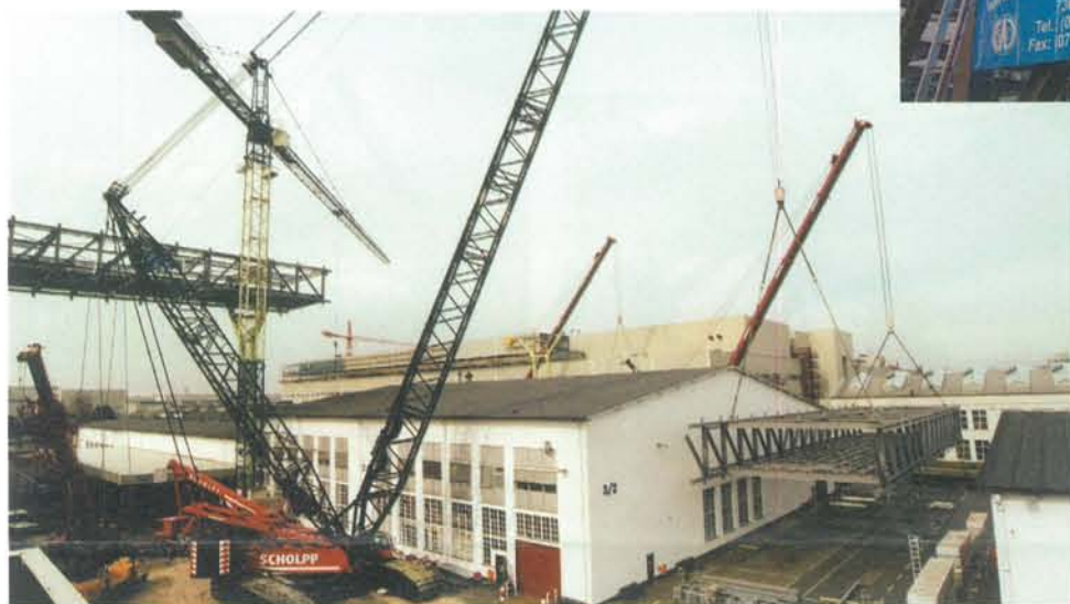
Teil 2 wird angehoben.
