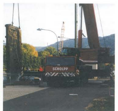
HK 200 beim Ausheben eines Schleusentores.
