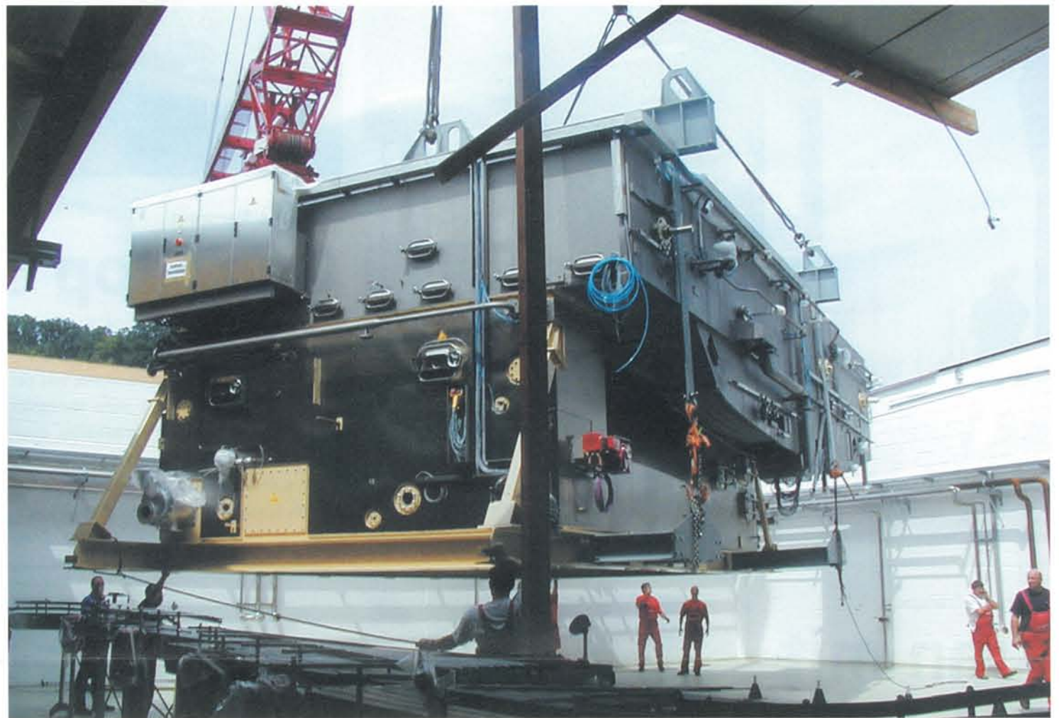
18 vorjustierte Stellfüße übertragen 60 to Gewicht auf die Decke!
