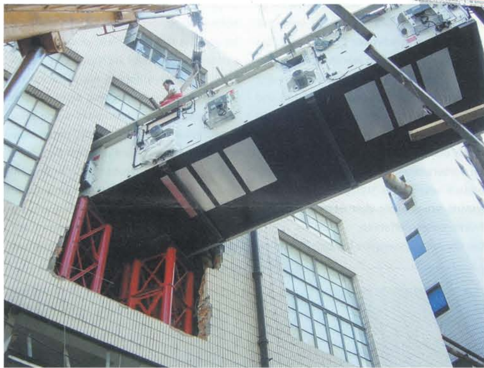
Einbringung des Trockners in 10 m Höhe.
