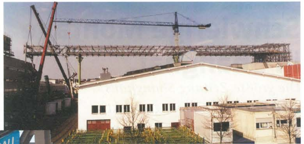
Gesamtansicht, mit Einheben von Teil 3.
