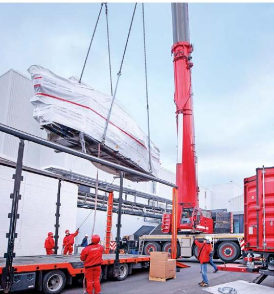
Auf der Transportliste standen eine Kartonniermaschine und eine Blistermaschine, welche Folien- oder Aluminiumpackungen für Tabletten oder Kapseln herstellen. Diese werden samt Beipackzettel in Kartonagen verpackt. Am ersten Tag transportierte SCHOLPP die Maschinen von Laupheim nach Freiburg. Am zweiten Tag stellte das fünf Mann starke Team einen Kran, mit dem die Maschinen abgeladen wurden.
