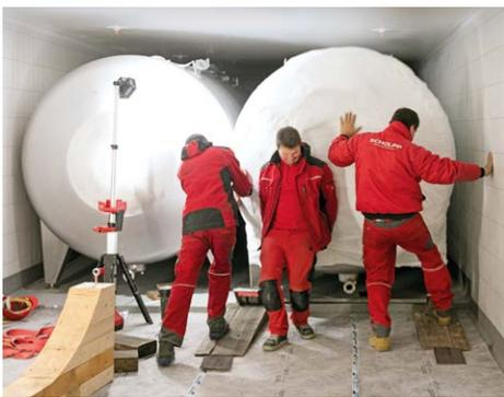
Auf der Agenda standen das Abladen und das Einbringen von vier neuen Tankbehältern in die Keller des historischen Gasthauses. Mit 12.000 Litern Fassungsvermögen erforderte der Transport einiges Fingerspitzengefühl. Der Platz zum Manövrieren war knapp bemessen: enge Einbringungsöffnung am Gebäude, Absenkung ins verwinkelte Kellergeschoss, Quertransport über schmale und niedrige Kellergänge.
