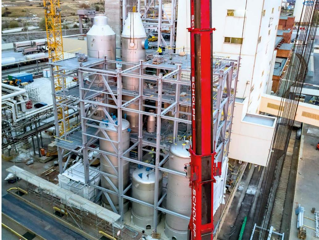
Die SCHOLPP-Ingenieure erstellten detaillierte Kranzugstudien. Zum Einsatz kam ein Terex AC 500 der SCHOLPP Kran & Transport GmbH, der über die zu den Raumbedingungen passende Mast- und Wippauslegerlänge verfügte. Im Zeitplan musste der Aufbau am Feiertag und ein Umbau von Hauptausleger zu Wippausleger bedacht werden.
