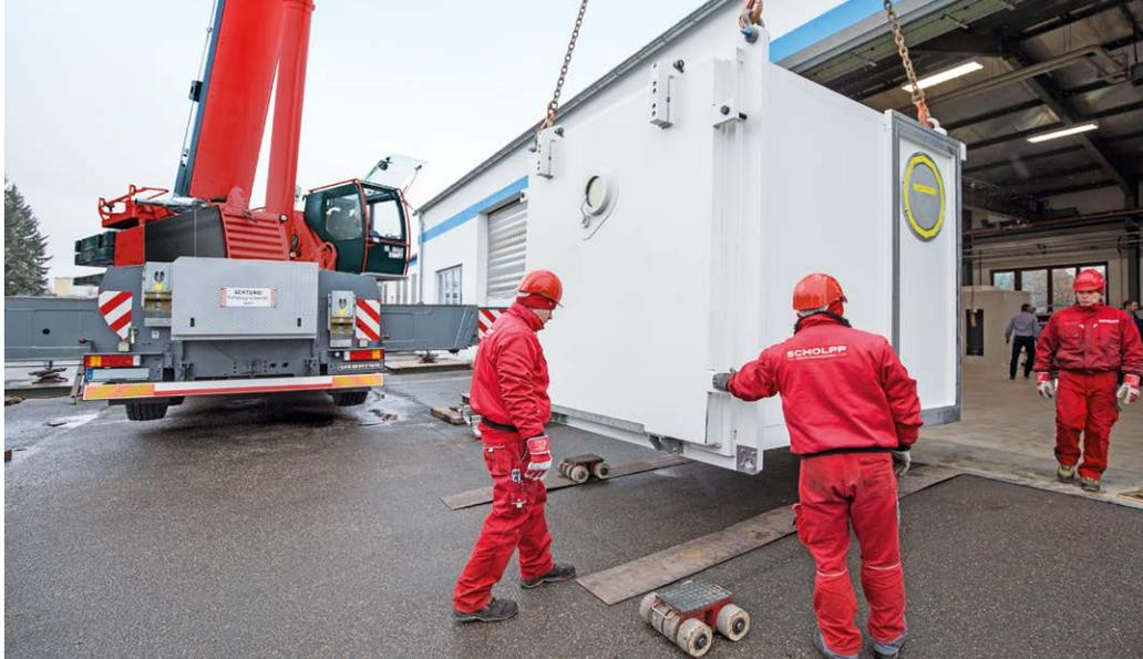
pro-beam systems GmbH: Einbringen einer Vakuumkammer
