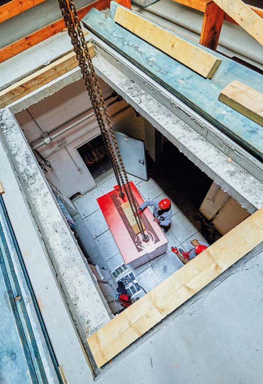
Kraft- und Lichtenanlagen GmbH, Rüdersdorf: Einbringung von Transformatoren
